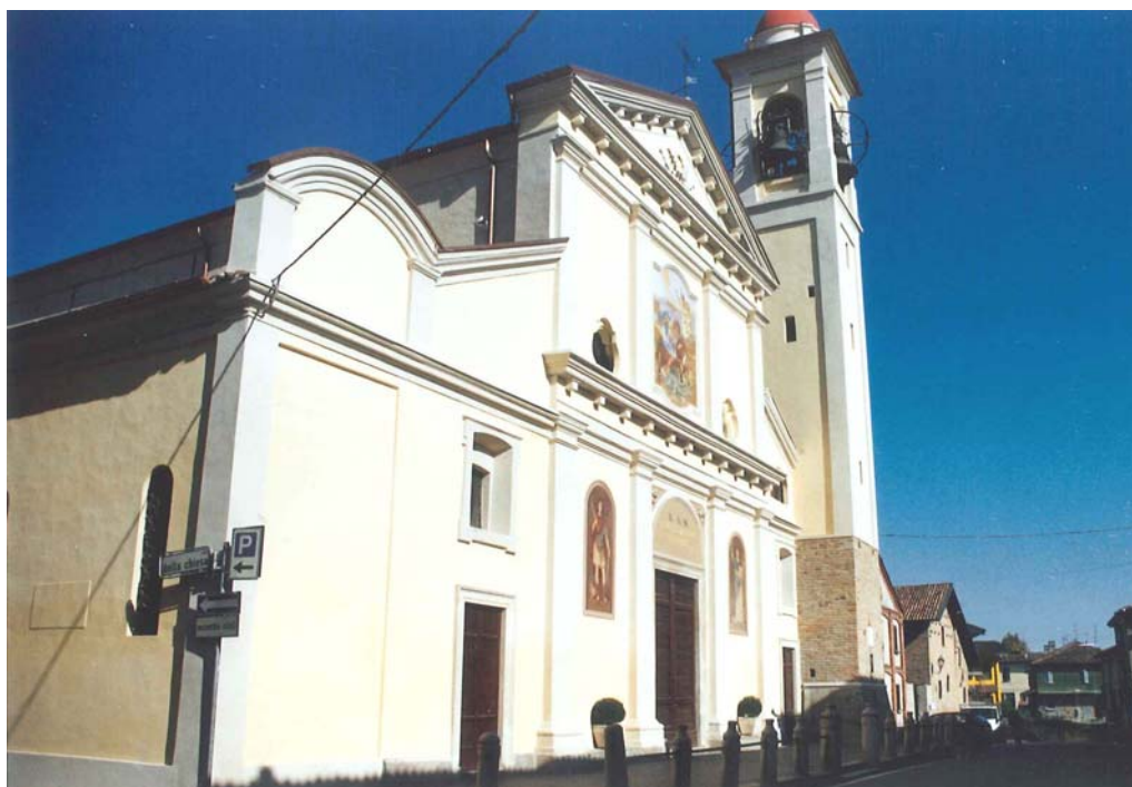
ESTERNO – LA Chiesa di San Giorgio dopo l'ultimo restauro
