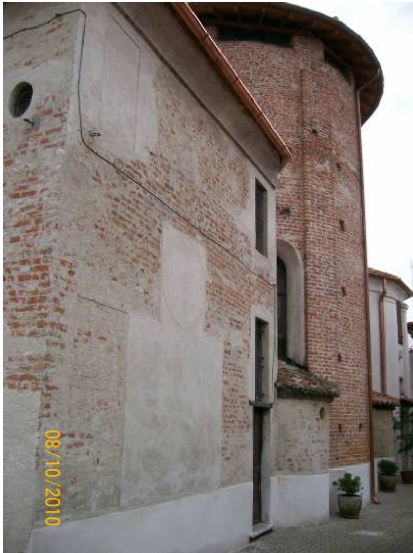
CHIESA DI SAN GIORGIO- ESTERNO- PARTICOLARE DELL'ABSIDE Si può notare ancora l'impronta di una vecchia meridiana.
