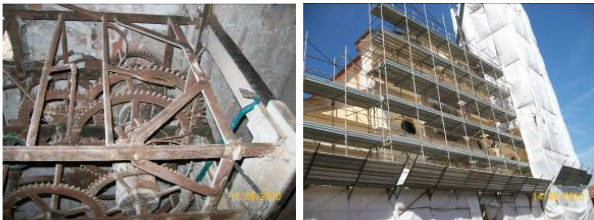
LAVORI DI CONSOLIDAMENTO E RISTRUTTURAZIONE ALLA CHIESA- Anno 2010 PRIMA FOTO A SINISTRA, L'IMPIANTO DELL'ANTICO OROLOGIO CHE ERA POSTO SUL CAMPANILE.
