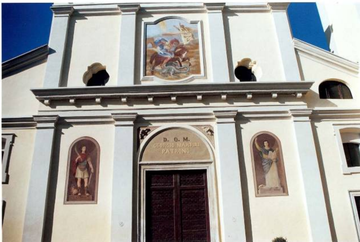
CHIESA DI SAN GIORGIO: La FACCIATA e gli AFFRESCHI del BARBOTTI, RESTAURATI.
